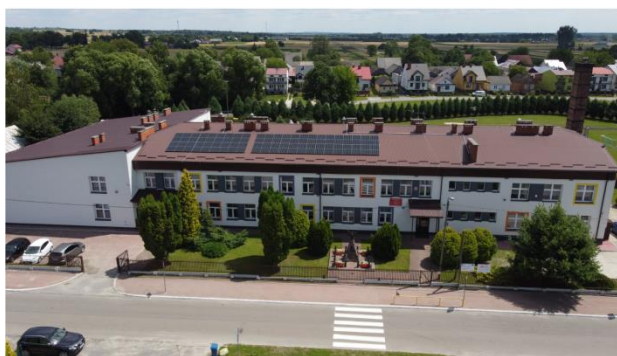
Ryc. 4. Budynek ZS w Dzwoli po termomodernizacji
