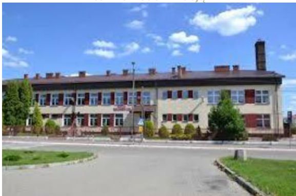
Ryc. 3. Budynek ZS w Dzwoli przed termomodernizacją
