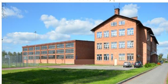
Ryc. 1. Budynek ZS w Kocudzy przed termomodernizacją
