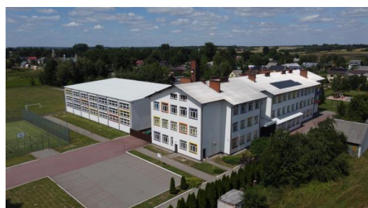
Ryc. 2. Budynek ZS w Kocudzy po termomodernizacji
