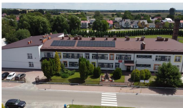
Ryc. 4. Budynek ZS w Dzwoli po termomodernizacji
