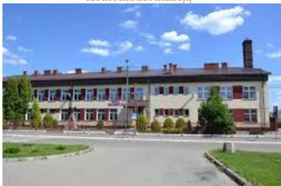
Ryc. 3. Budynek ZS w Dzwoli przed termomodernizacją
