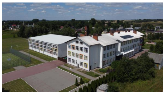
Ryc. 2. Budynek ZS w Kocudzy po termomodernizacji
