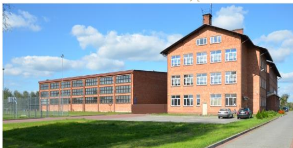
Ryc. 1. Budynek ZS w Kocudzy przed termomodernizacją
