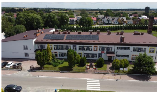
Ryc. 4. Budynek ZS w Dzwoli po termomodernizacji
